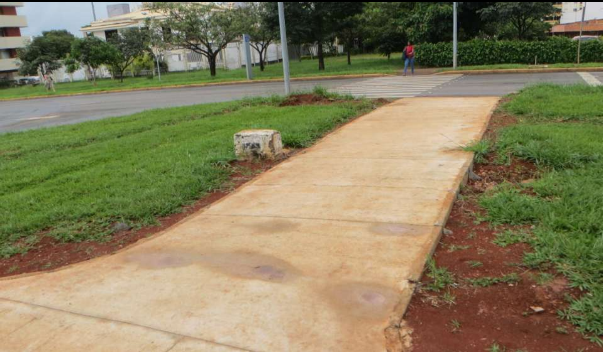
Ponto de acesso com faixa de pedestre deslocada
