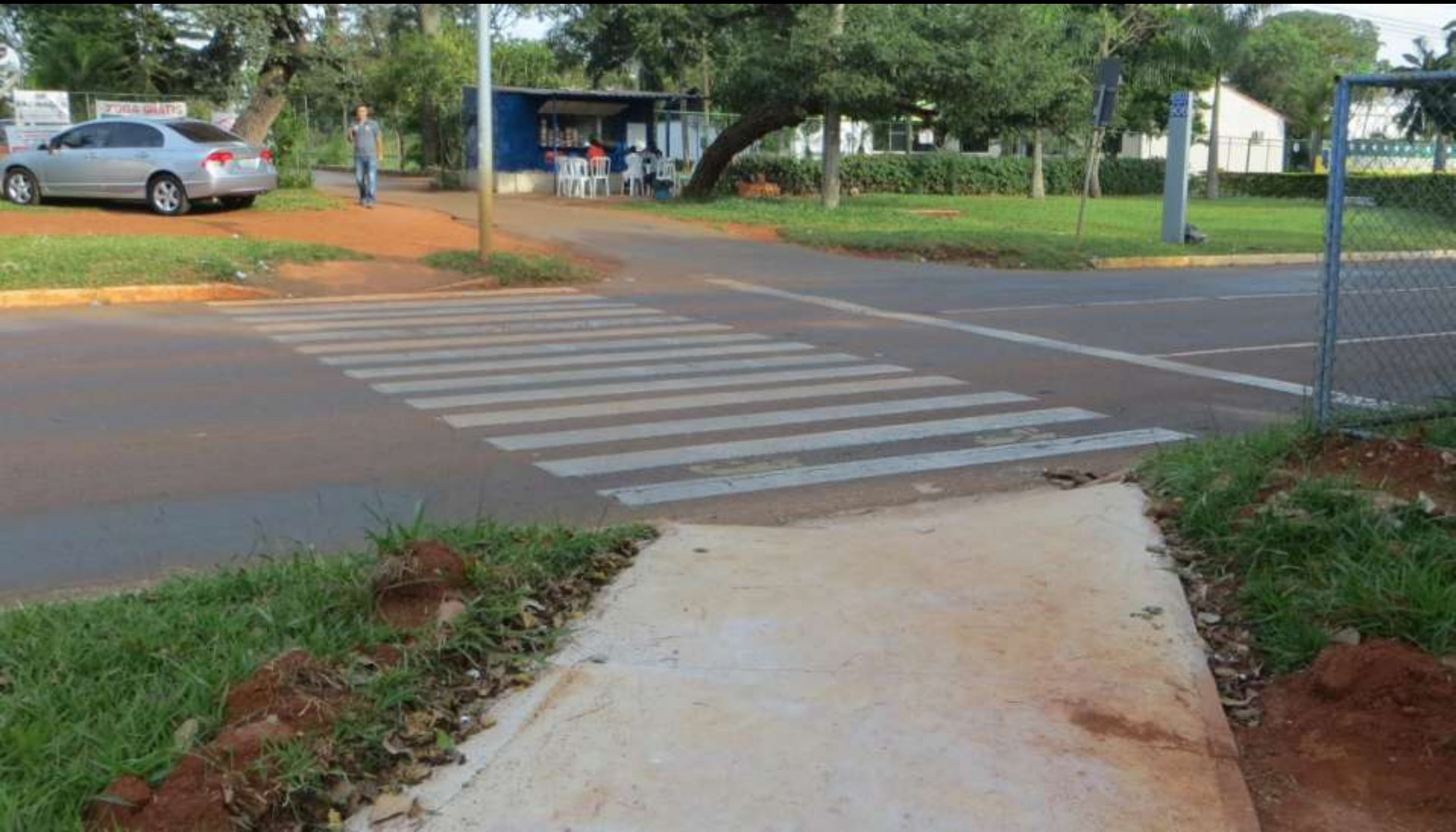
Ponto de acesso com faixa de pedestre. Ausência de ciclovia ou calçada no lado oposto.
