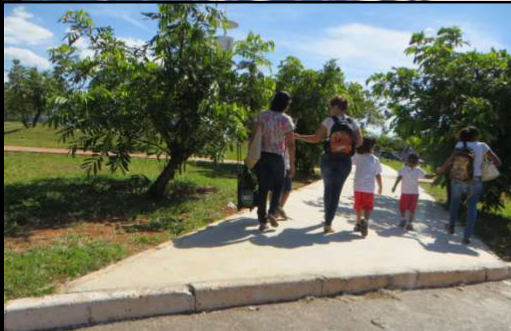
Local de travessia sem qualquer sinalização e sem rebaixamento de guia
