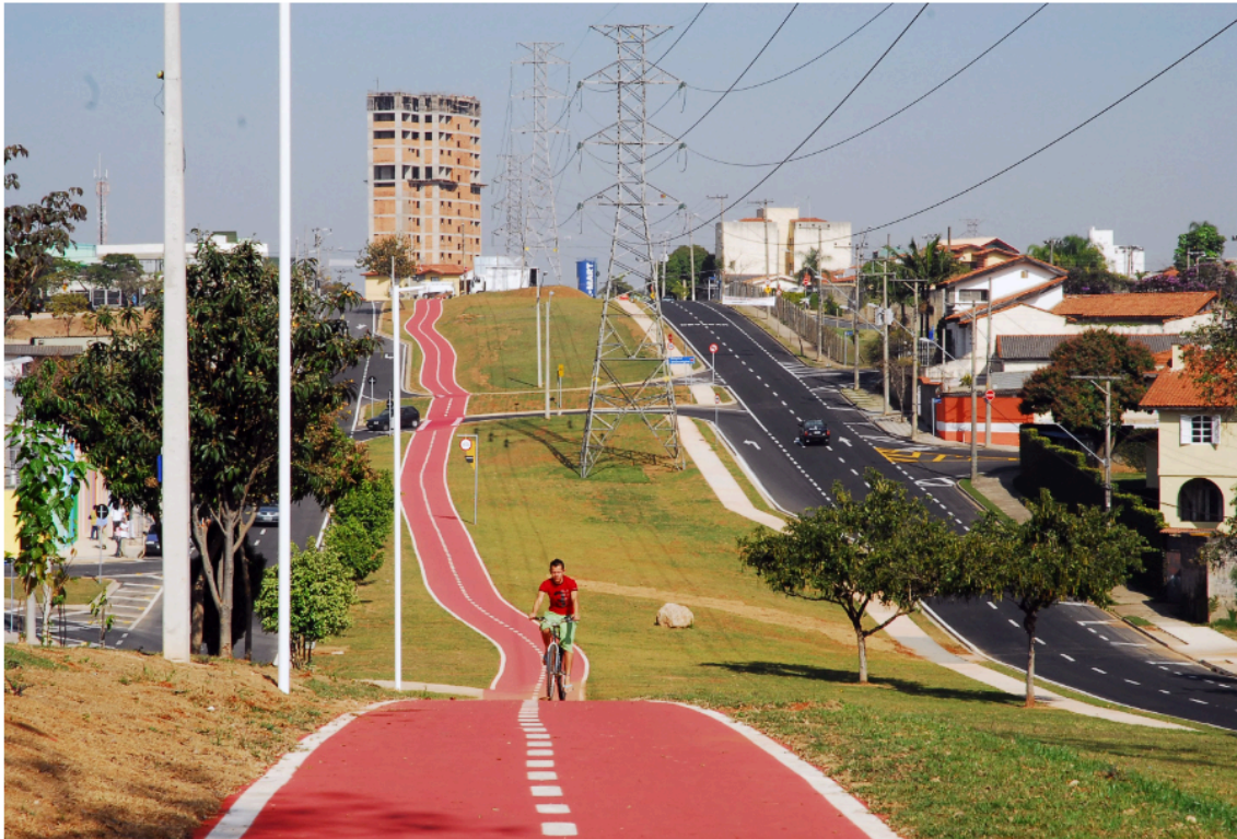
Figura 03: Foto de Zaqueu Proença. Infraestrutura cicloviária implantada em Sorocaba (2016). Fonte: URBES
