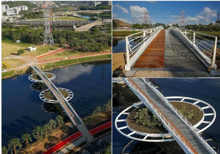
Figura 10: Ponte móvel para pedestres e bicicletas sobre canal Guarapiranga na margem oeste
