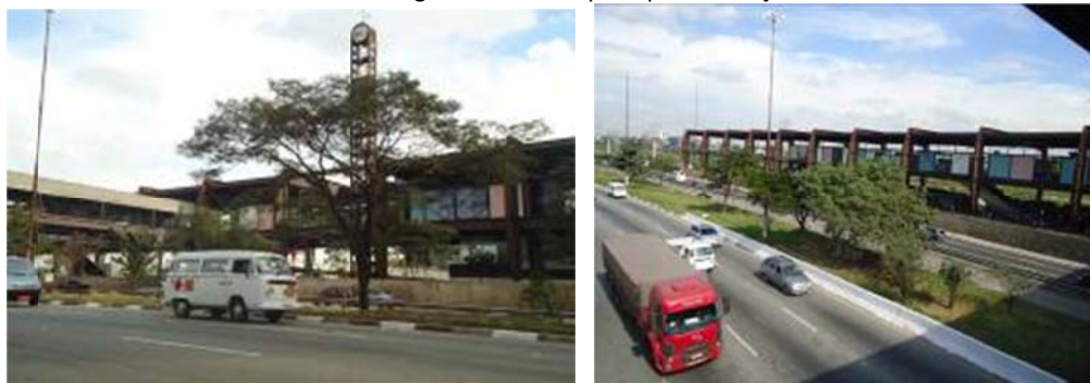
Figura 3: Fachada principal da estação de trem
